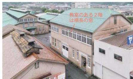
教室のある2階には採光のため横長の大きな窓が設けられています。1階は他の建物と同様に縦長の窓で、当初から倉庫だったようです。
